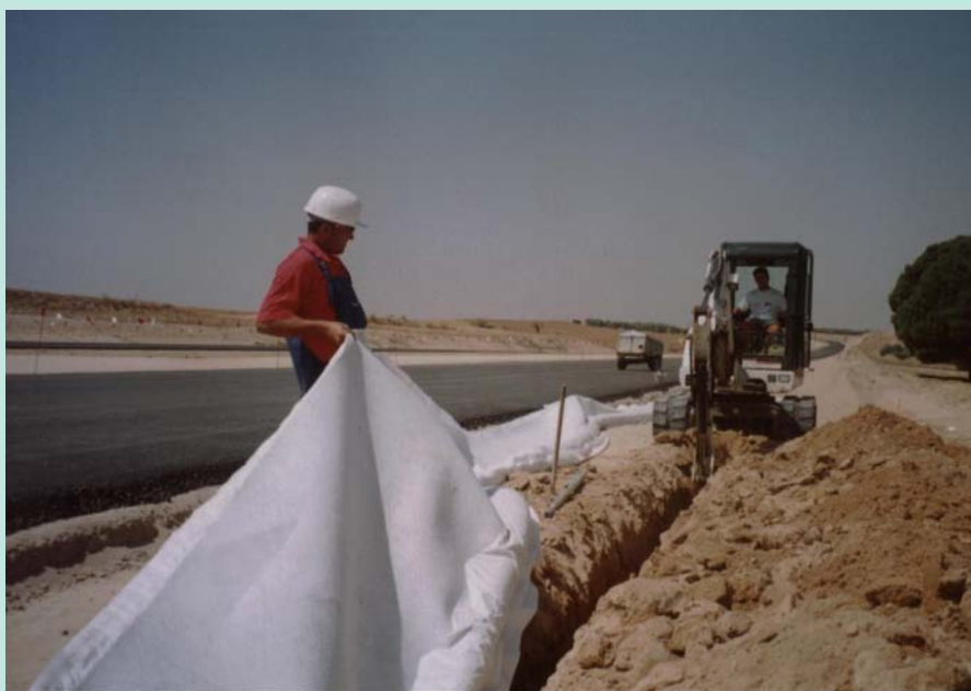
Colocación del sistema VIADRAIN en la zanja
