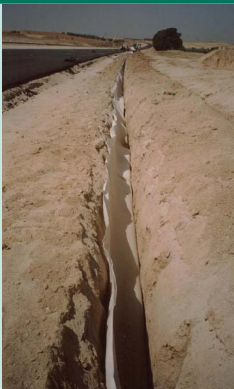
Sistema VIADRAIN clocado e instalado en la zanja
