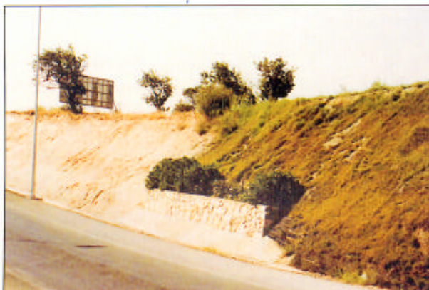
Resultados obtenidos con la instalación de malla TRINTER en comparación con zonas sin actuación.
