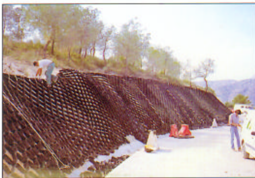
Geoceldas de confinamiento. Apeadero Terra Mítica. Mayo 2000.
