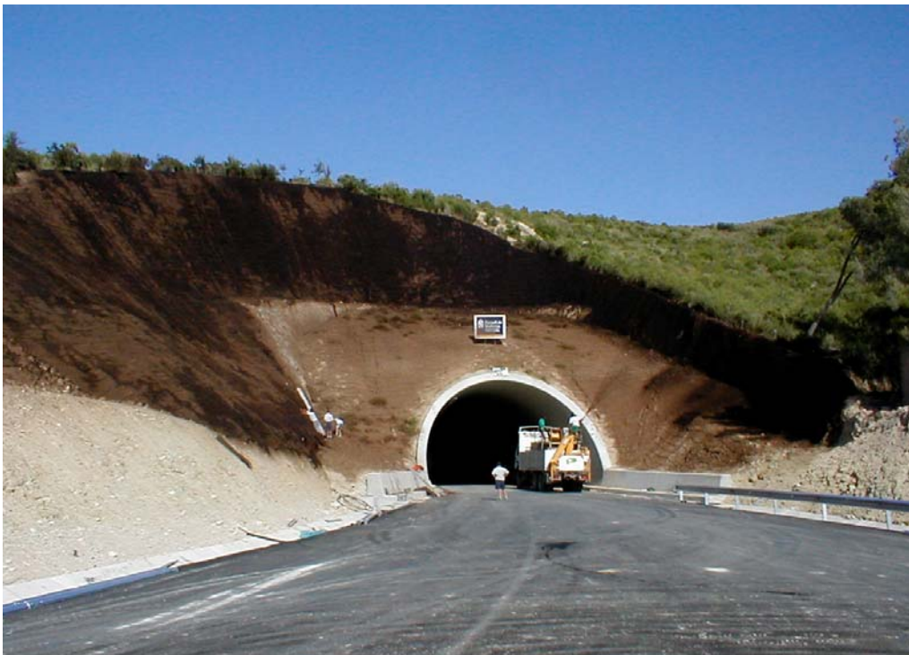
4. Proyección de sustrato para el relleno de la malla TRINTER. Tratamiento de hidrosiembra
