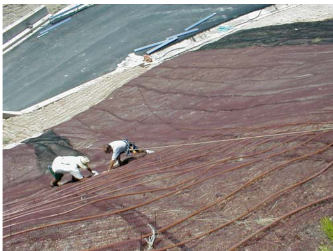
2. Instalación del sistema de riego por goteo
