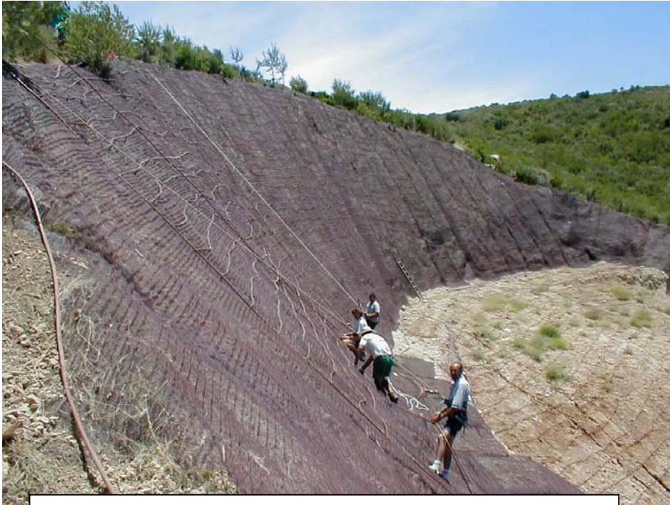
3. Fijación de la malla y las líneas de riego
